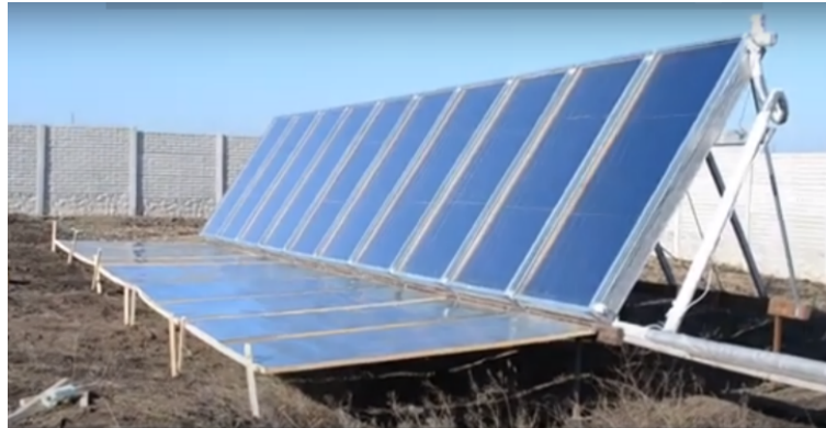
Рис. 1. Сонячний колектор з відбивачем сонячних променів.
